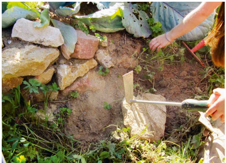
Mauerbau aus Grassoden und Kalksteinen
